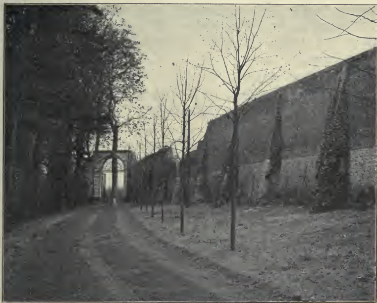
LES VIEUX MURS DE 1649-1650.
